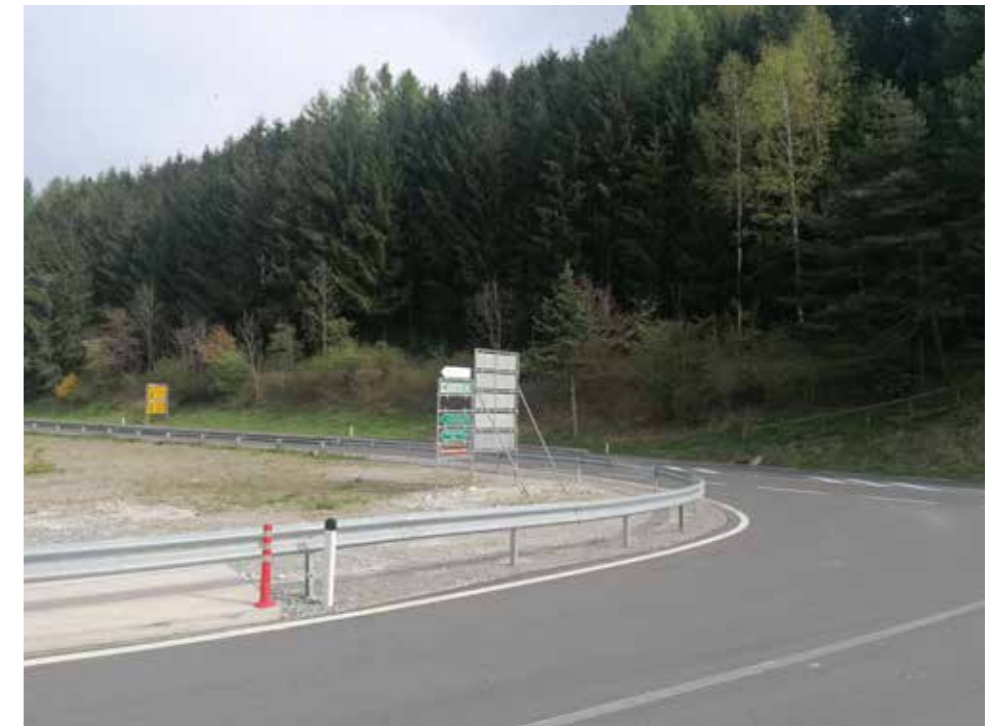
Abzweigung B98 ins Krastal (Krastalbrücke) (eigene Aufnahme)
