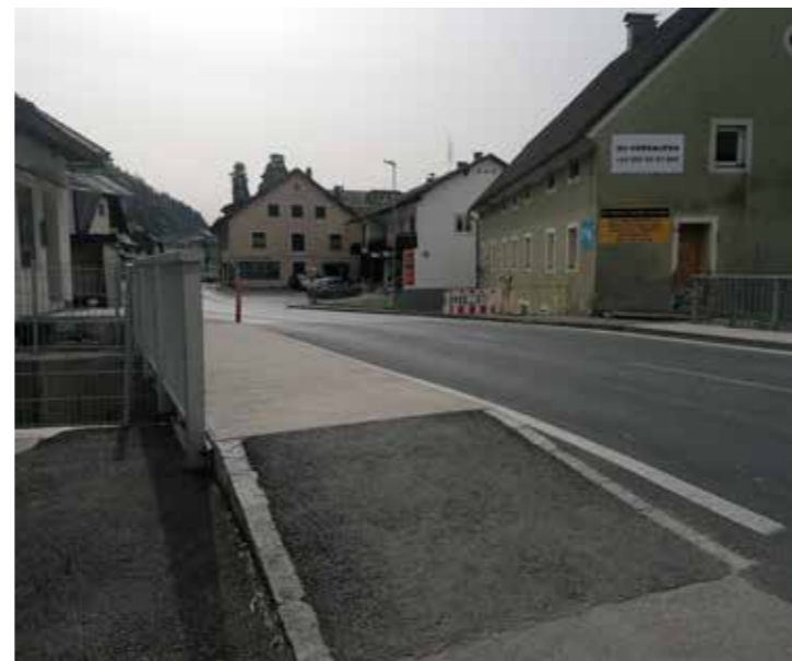
Gehsteig - Brücke Pöllingerbach (eigene Aufnahme)
